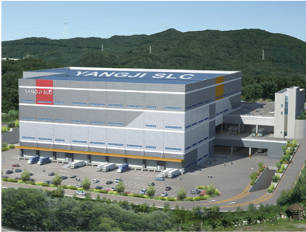
양지SLC물류센터 UNIT COOLER 54 SET SCREW 냉동기 10 SET 냉각탑 300RT 4 SET 냉동 DUCT
