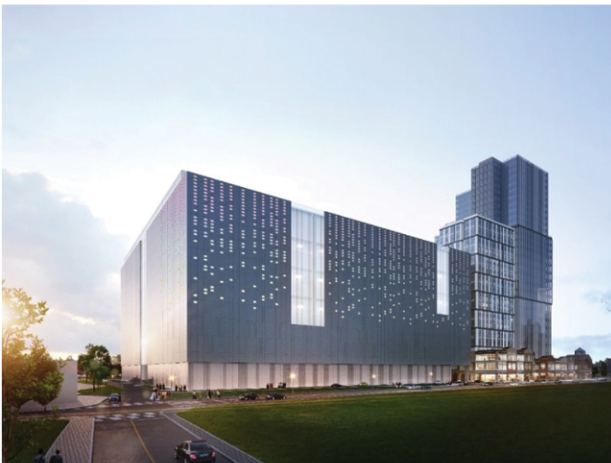
오산클라우드M캠퍼스 연면적 152,268.64m2 대형 물류창고 UNIT COOLER 172 SET SCREW 냉동기 12 SET 냉각탑 350RT 7 SET
