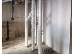
안산 메트로푸르지오힐스테이트 기계설비공사 연천군 은대지구 공동주택 기계설비공사 급배수 위생배관 / SR-JOINT 이중관 소방배관 / C-PVC
